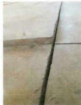
Foto 6: MANTENIMIENTO DE PISO DE UN AULA
