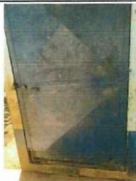
Foto 3: MANTENIMIENTO DE PUERTAS.
